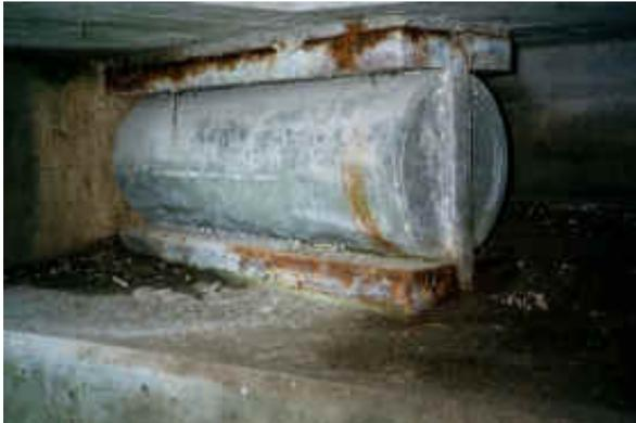
Rollenlager einer Brücke mit beginnender Korrosion
